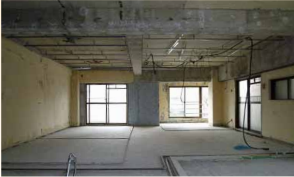
スケルトンの状態 躯体に問題がないかインスペクションを実施
