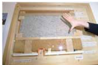
30cm以上ある壁の断面模型、手前が部屋の内側
