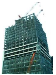
建築中の豊田毎日ビル
