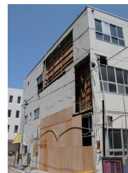
鉄骨造3階建て外壁の脱落
