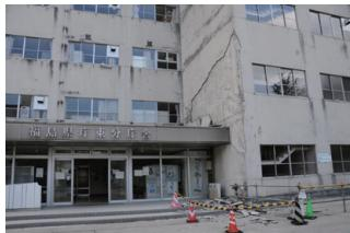
壁面のモルタルが剥がれ落ちる
